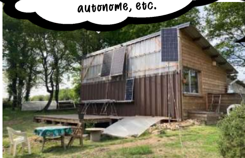
Figure 25. Cabane en bois, centre Bretagne.
